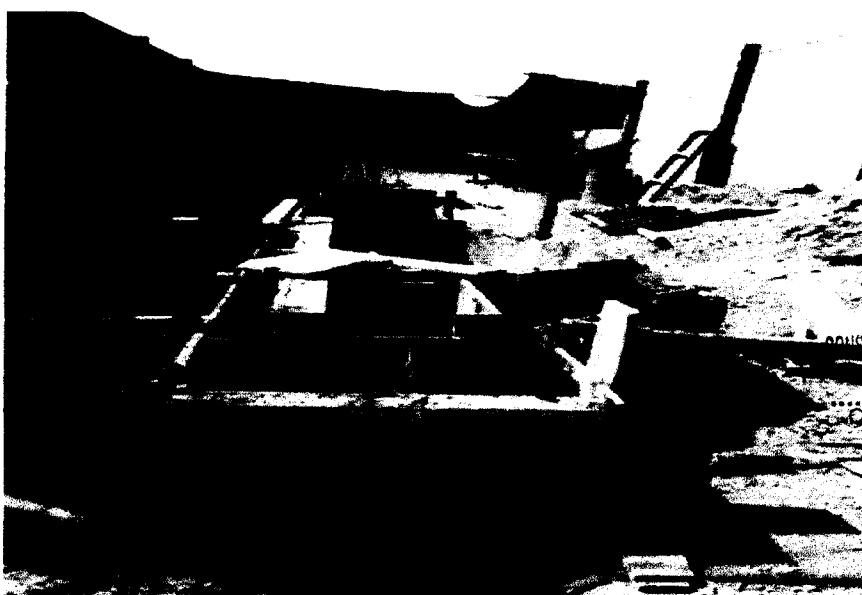
Figura 3: Armadura de Acero, Encofrado y Vaciado de concreto para camara de Rejas.
